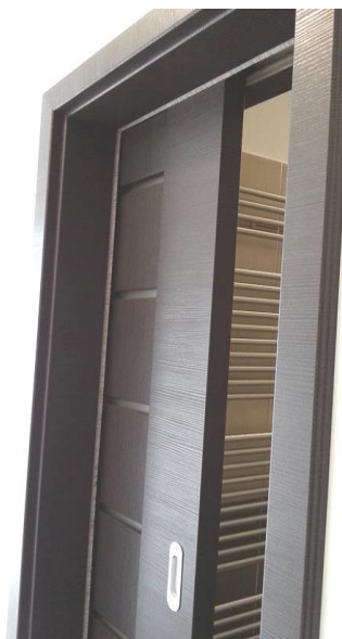
Posuvné křídlo do zazděného pouzdra
